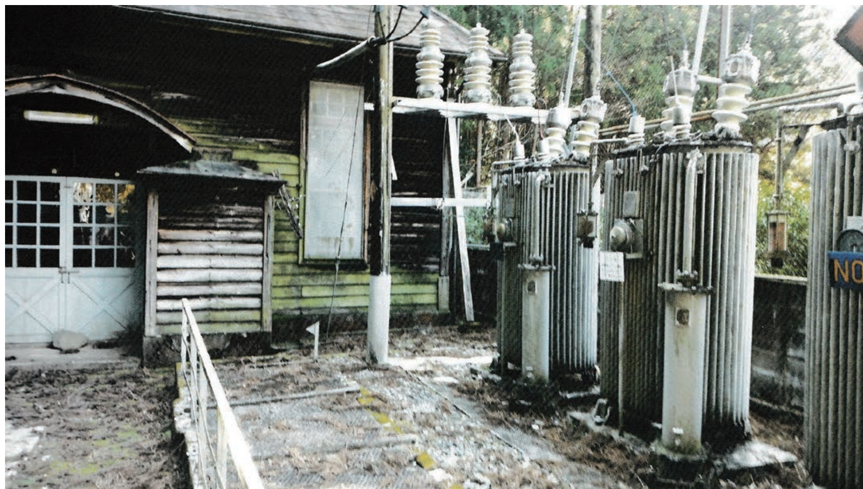
修復工事前の神通発電所
