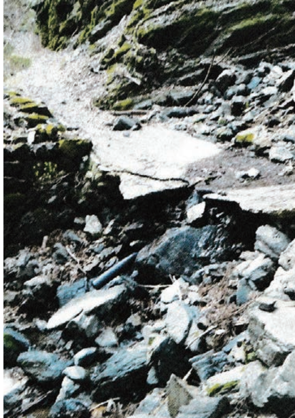
崩れた旧遊歩道
